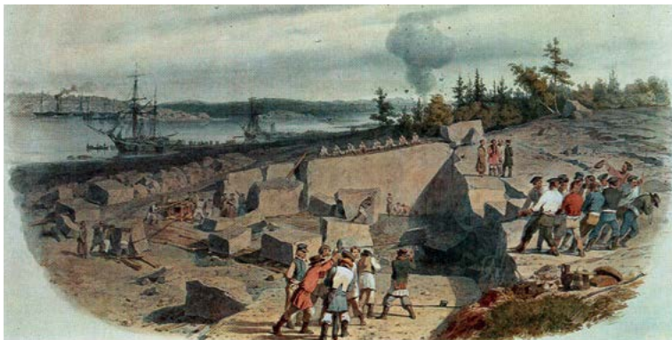
Пютерлакская каменоломня под Выборгом. Отсюда гранитные плиты доставлялись в Кронштадт
